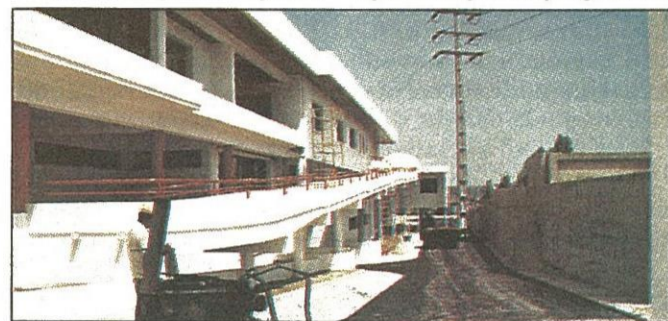
Estado actual das obras da Nova Sede
