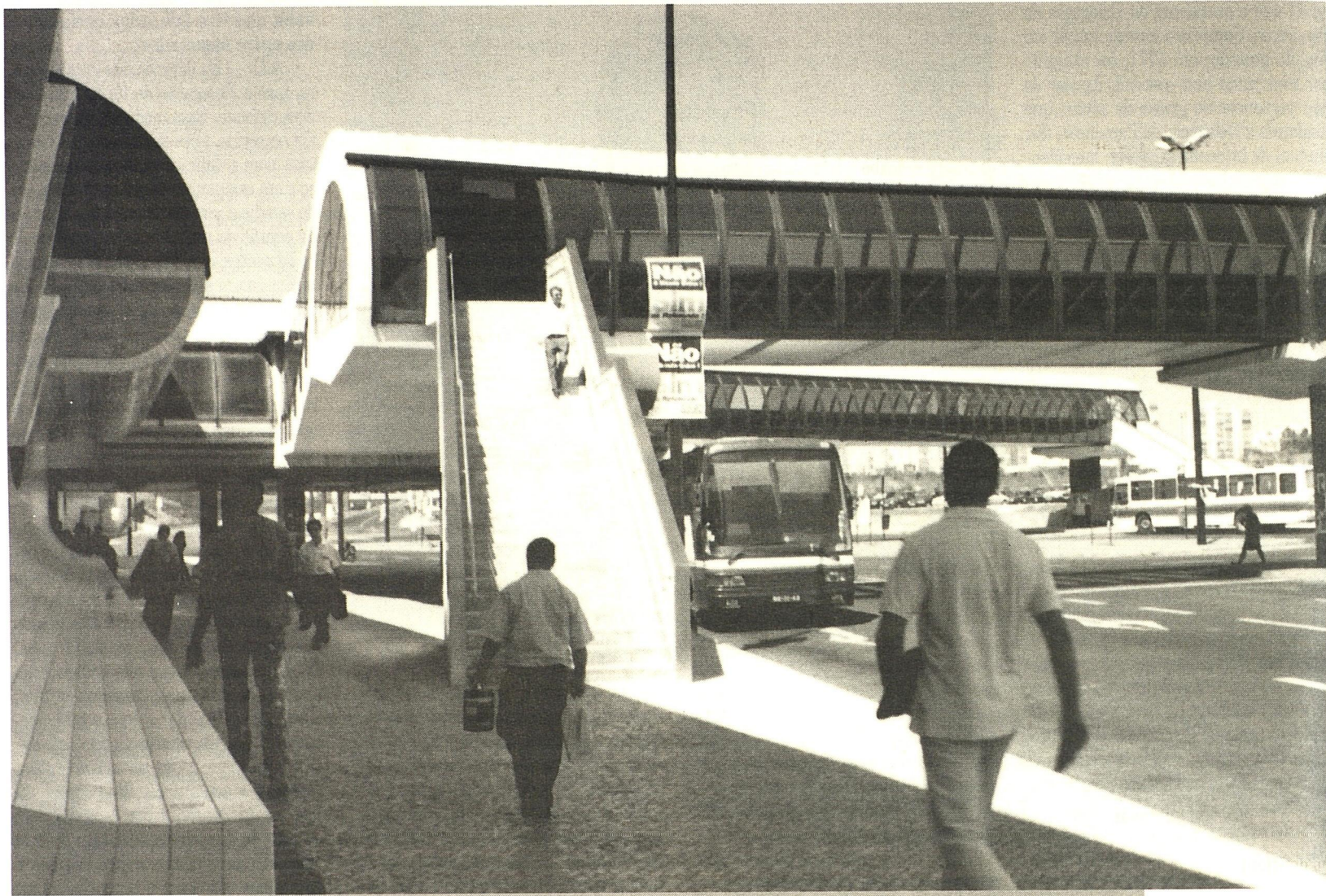
No novo interface do Campo-Grande, apesar das placas de orientação para invisuais, as cadeiras de rodas continuam sem acessos
