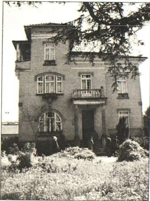
Prédio da Rua de Francos
