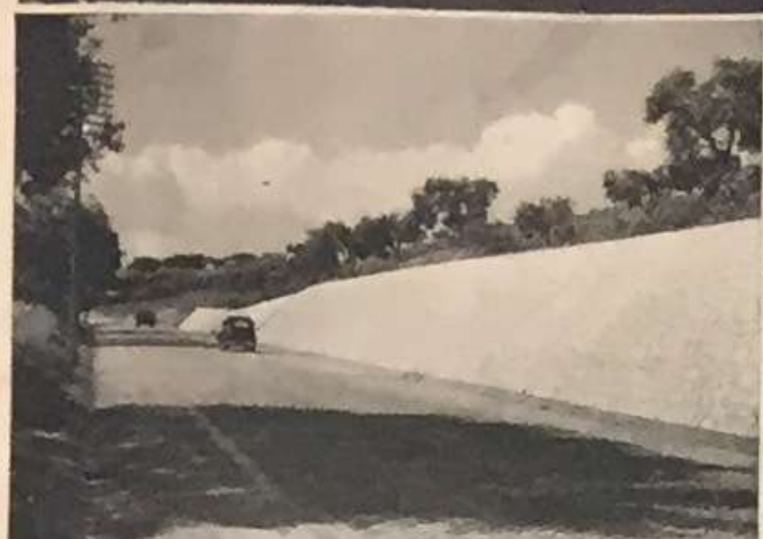
PAVIMENTO DE PARALELÍPIDOS (PRÓXIMO DE COIMBRA)
