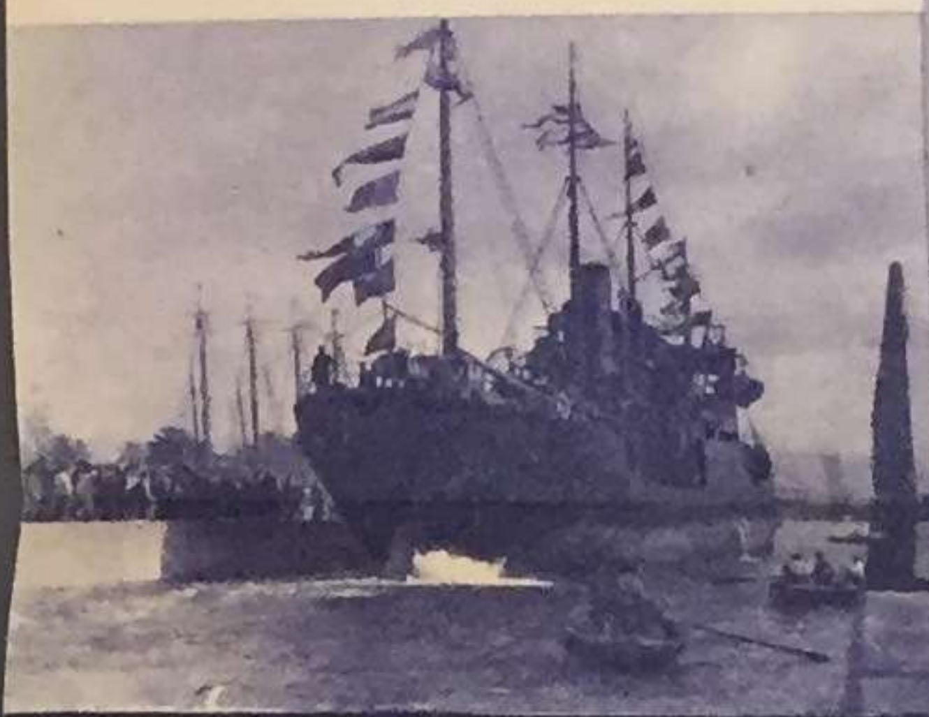
ENTRADA DO PRIMEIRO NAVIO NA NOVA ECLUSA DA DOCA DE FLUTUAÇÃO DE VIANA DO CASTELO
