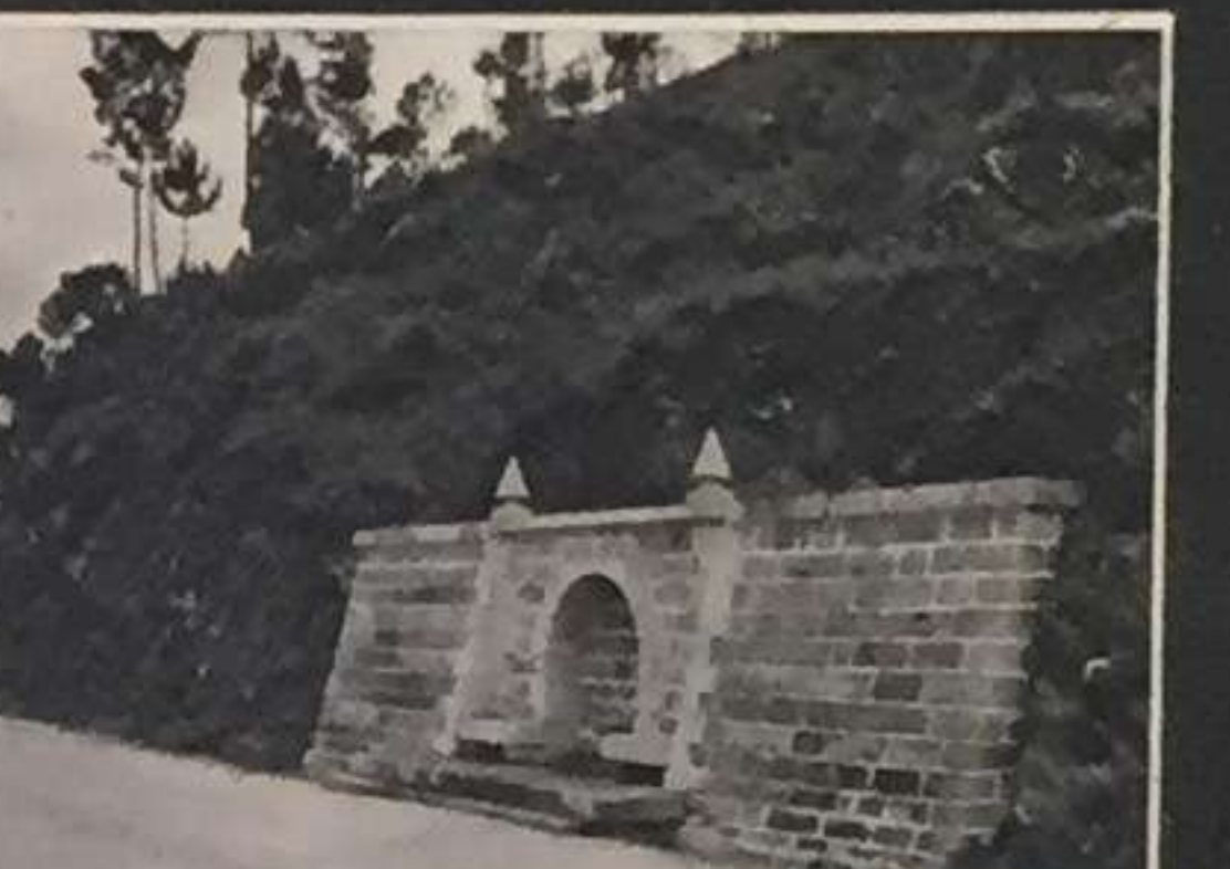
OBRAS COMPLEMENTARES - CHAFARIZ (DIST. DO PORTO)
